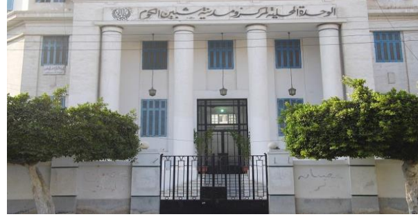
شكل (6) مبنى مجلس المدينة، شبين الكوم، المنوفية، مصر. المصدر: الباحث
