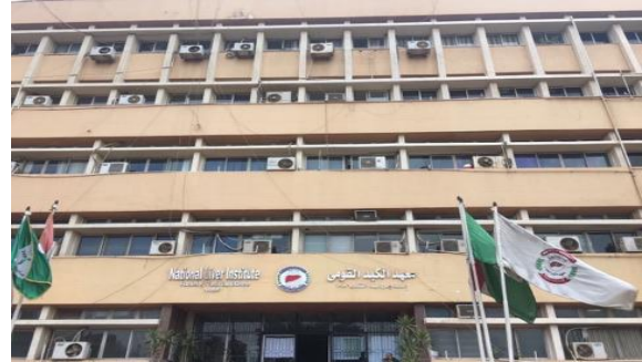
شكل (7) مبنى معهد الكبد القديم، شبين الكوم، المنوفية، مصر، عام 1987م. المصدر: الباحث
