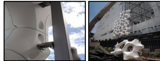
شكل (19) تفاصيل تركيب الوحدات المودبولية المطلية ثاني أكسيد التيتانيوم على شبكة من الحديد (غ)
