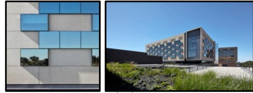
شكل (20) استخدام الزجاج العاكس لأشعة الشمس الضارة في واجهات مستشفى نيو بنديجو (ق)
