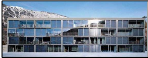
شكل (9) استخدام زجاج الحماية من الأشعة فوق البنفسجية النانوي في مبنى رعاية المسنين بسويسرا. (ر)
