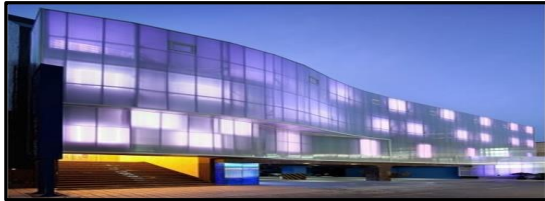
شكل(18) الواجهة التي استخدم فيها زجاج التحكم الشمسي(ف)
