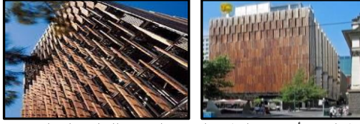
شكل (6) أستخدام الخشب النانوي المحسن للتغلب على التغيرات المناخية الأستوائية بمبنى القصلية بميل بورن بأستراليا. (خ)
