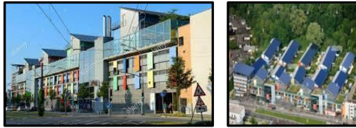
شكل (13) استخدام الألواح المفرغة بمركز سفينة الشمس وسط مدينة فرايبورغ بألمانيا. (ض)
