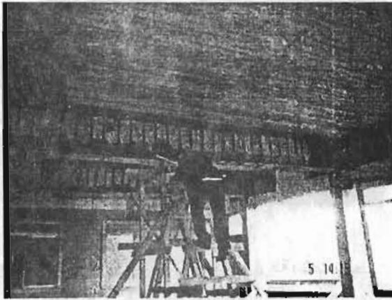
شكل ٢٥ يوضح بعض الكمرات الرئيسية بعد التدعيم
