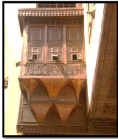
شكل (12) إستخدام المشربية لتجانس الإضاءة
